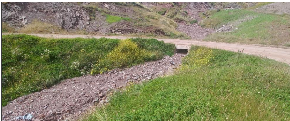
FIGURA N°01: TRAMO CRÍTICO EN LA QUEBRADA PUNKURAYOC, DISTRITO DE POROY, PROVINCIA DE CUSCO, SE APRECIA EL CAUCE COLMATADO.
